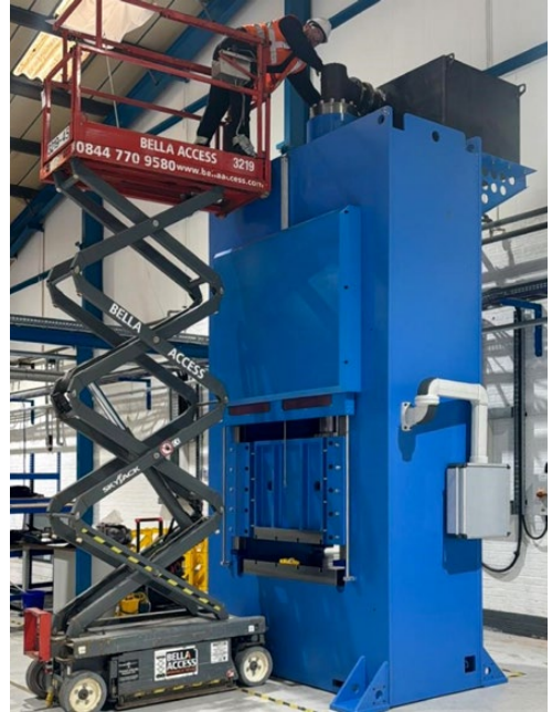
Installation of a special 300 ton press with 1000 mm stroke Installation einer speziellen 300 Tonnen Presse mit 1000 mm Hub Installation d'une presse spéciale de 300 tonnes avec une course de 1000 mm Instalación de una prensa especial de 300 toneladas y 1000 mm de carrera
